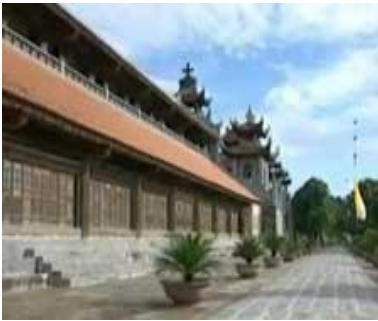
Nhà Thờ Lớn nhìn từ phía sau
