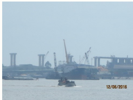
Cầu Vàm Cống đang xây cất
